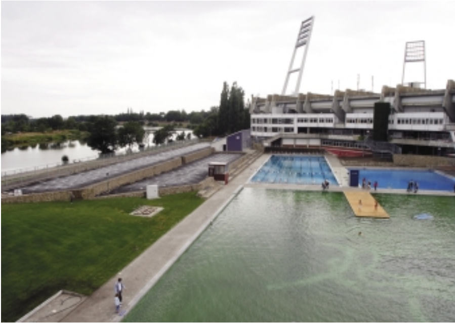
Die Filteranlage trennt das Freibad von den Weserauen; Foto: Bremer Bäder
