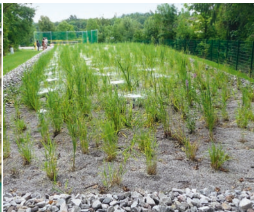
Das zu reinigende Beckenwasser wird über dem Neptun Bodenfilter verregnet und rinnt vertikal durch das Filtergranulat.
