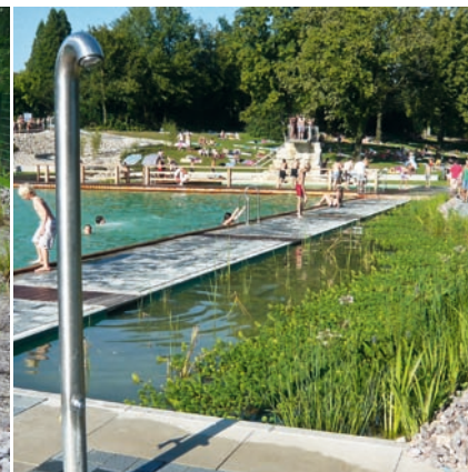
Am Beckenrand liegen die Regenerationszonen. Ist das Wasser gereinigt, wird es wieder in den Nutzbereich geleitet.
